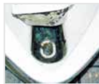
尿石が軟化して剥離している
