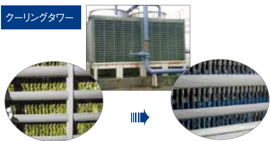
WW処理後 スケールが取れ、熱効率の上昇
